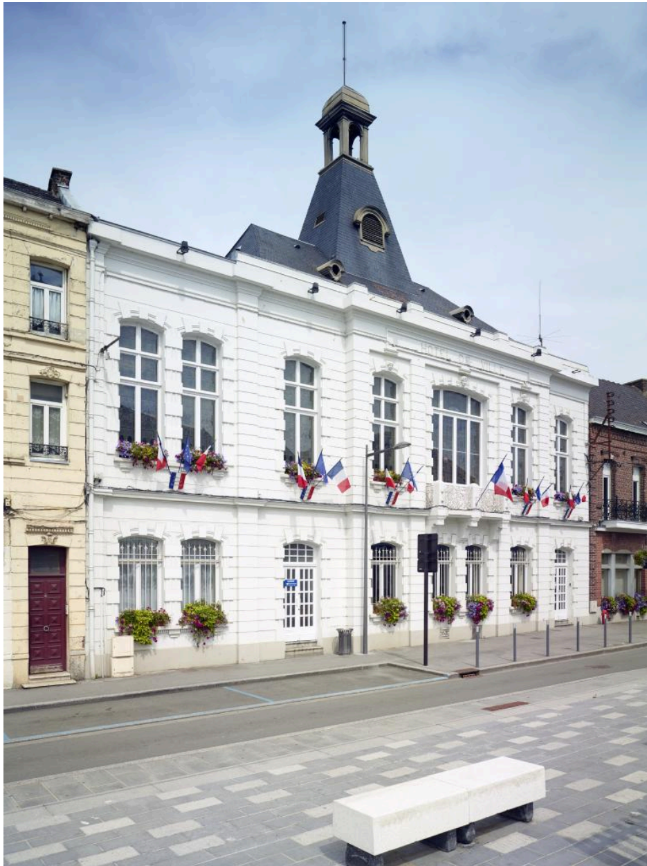
Elévation antérieure de la mairie, vers l'est.
