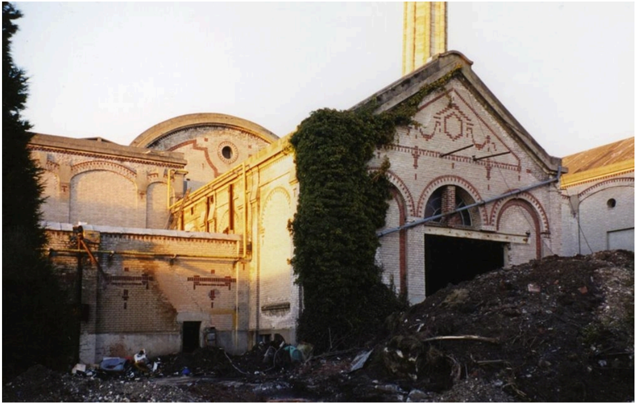
Chaufferie et blanchisserie à l'arrière-plan, 2001.
