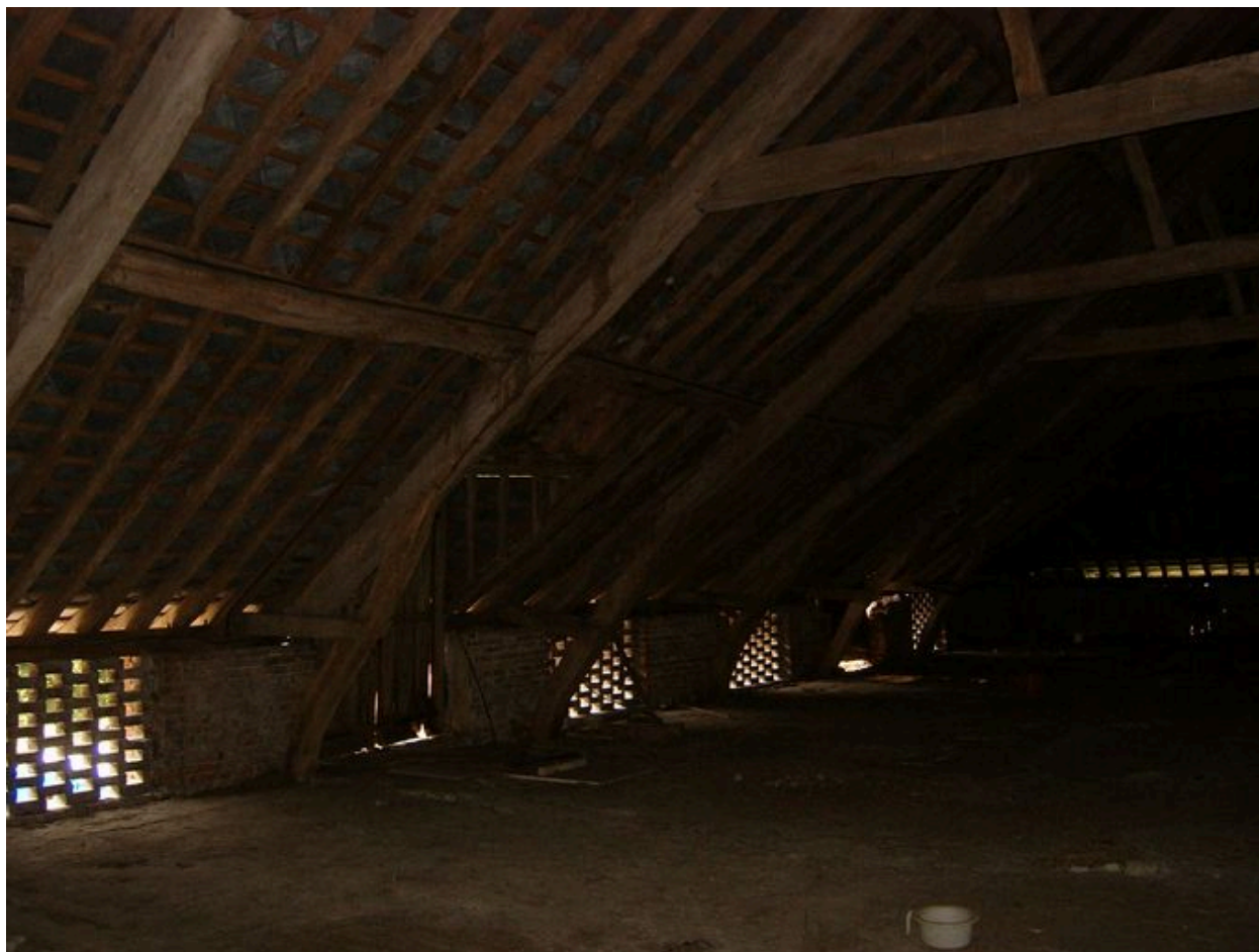
Vue détaillée de ces aérations.
