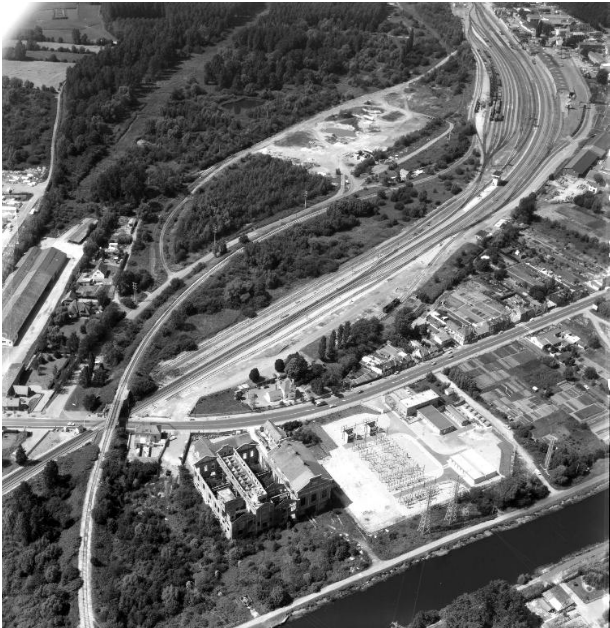
Vue aérienne de 1990, flanc est
