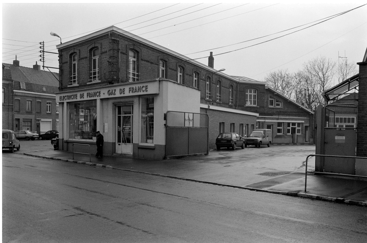
Bureaux. Vue prise vers l'est.
