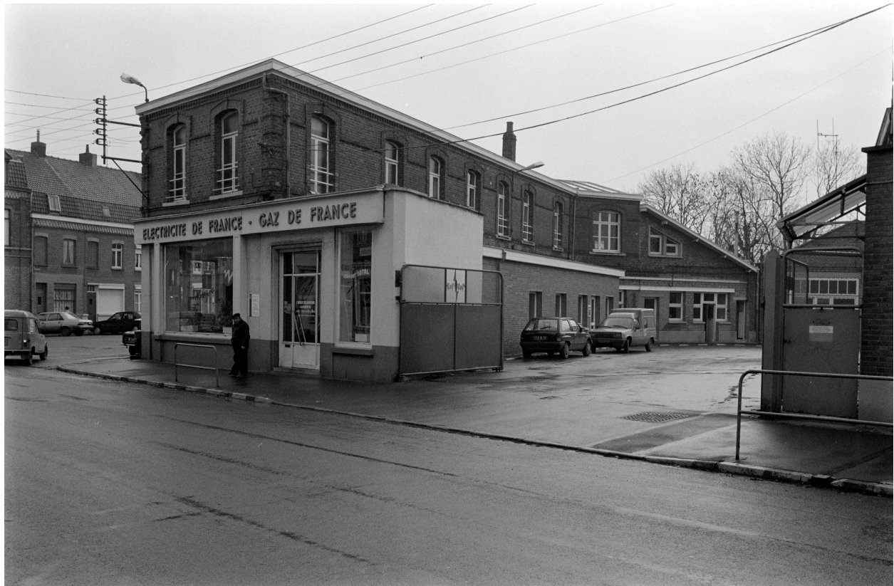
Bureaux. Vue prise vers l'est.
