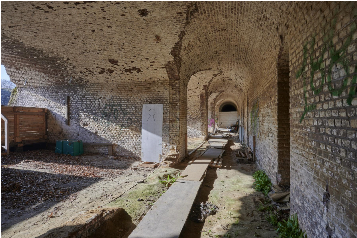
Aile est. Couloir sous la crête d'artillerie.
