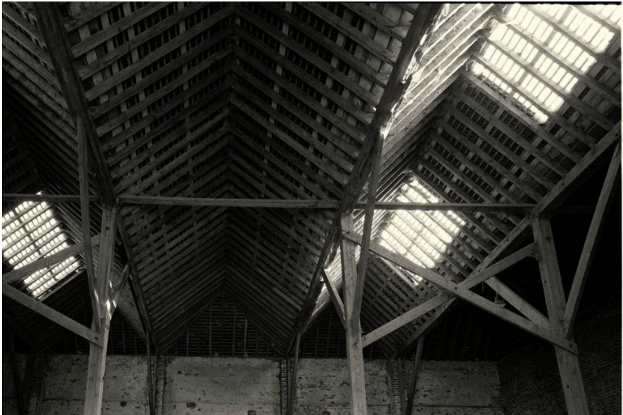
Charpente de la grange.
