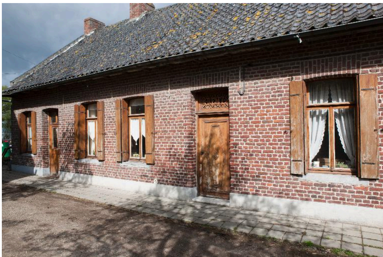
Vue générale du logis de la ferme 257 rue du Bois.
