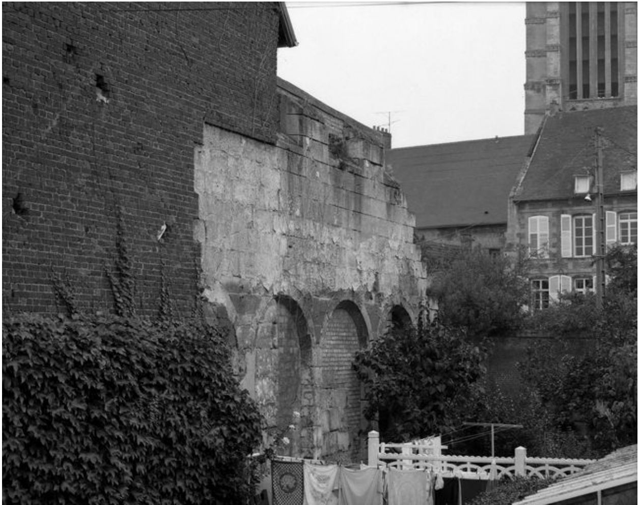
Vestiges du mur gouttereau nord.
