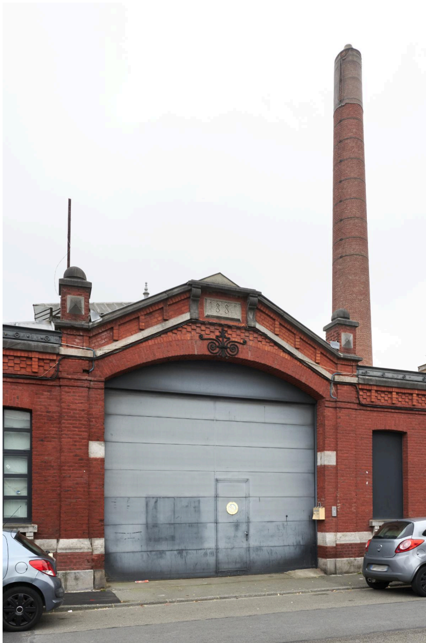
Cheminée d' origine, détail.
