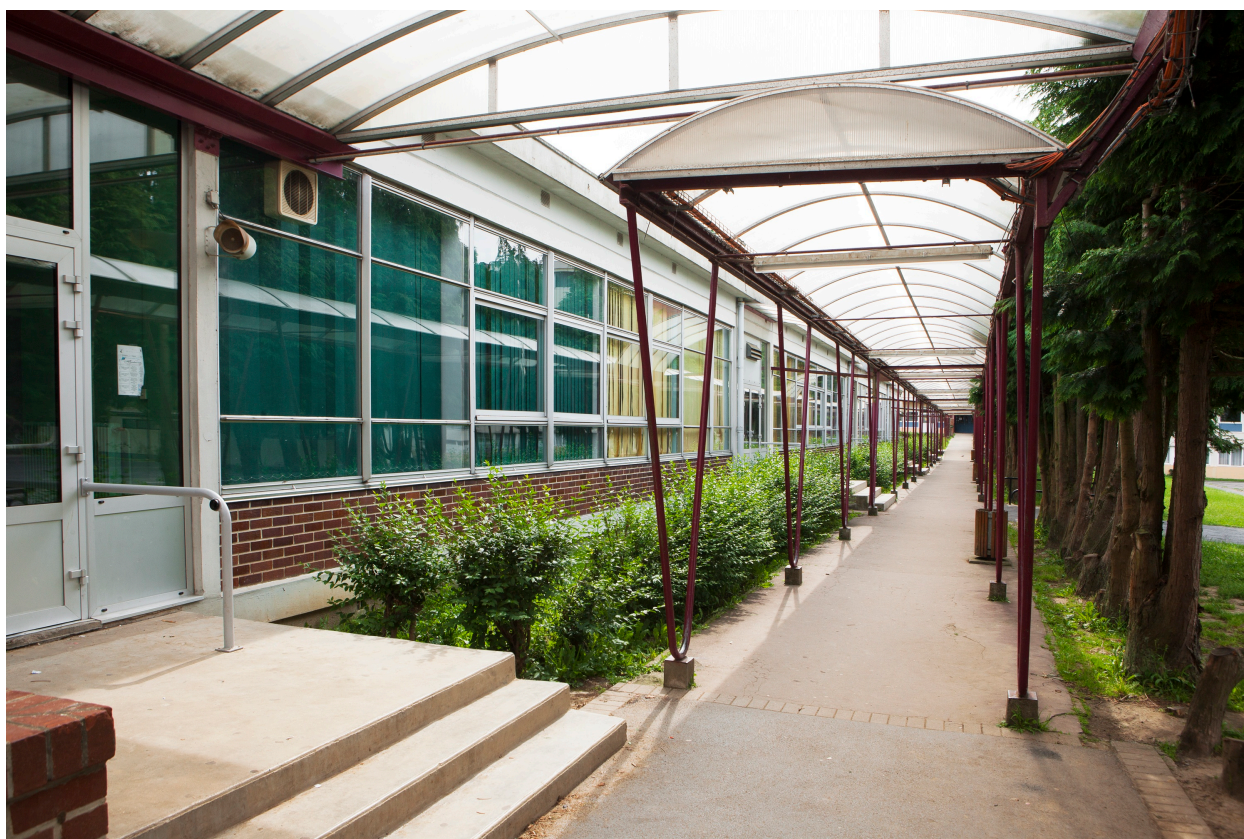
Demi-pension : façade sud et galerie, 2016 (détruit en 2017).
