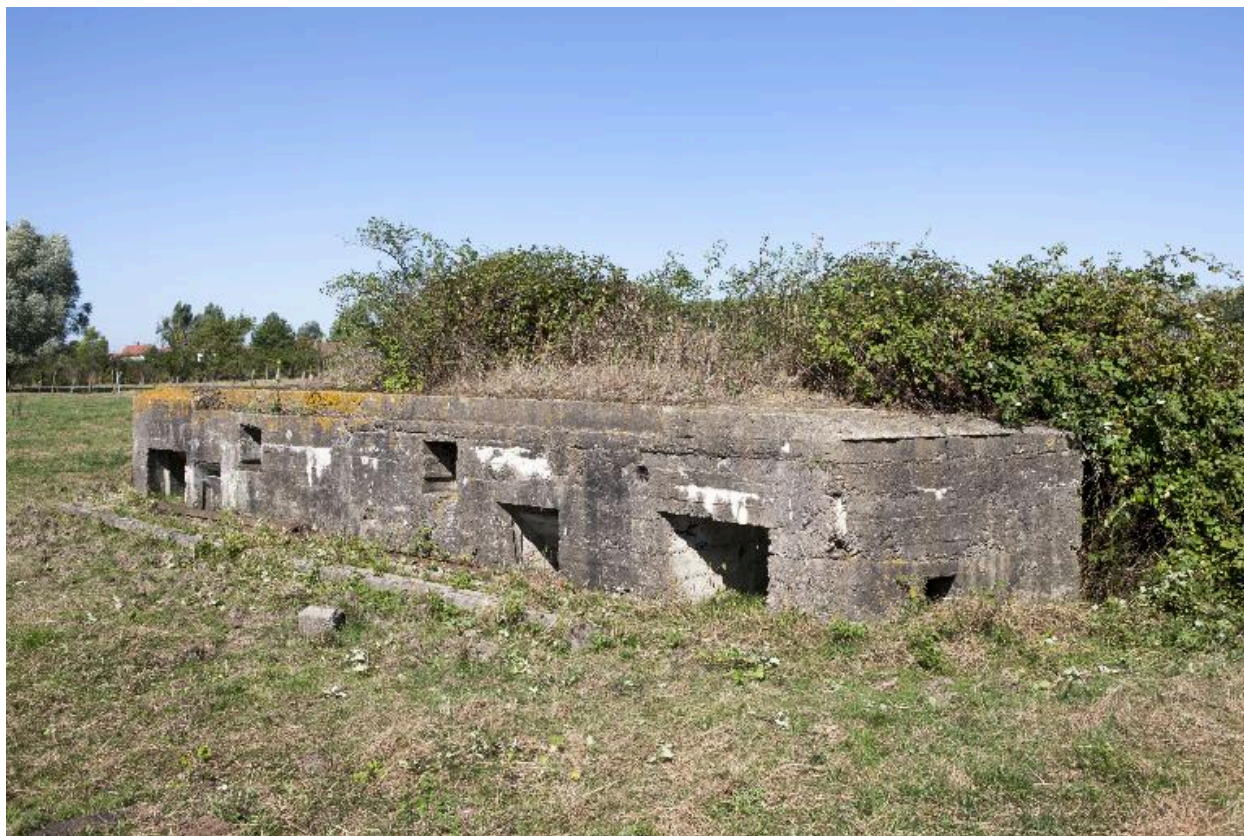
Vue générale vers le nord-ouest
