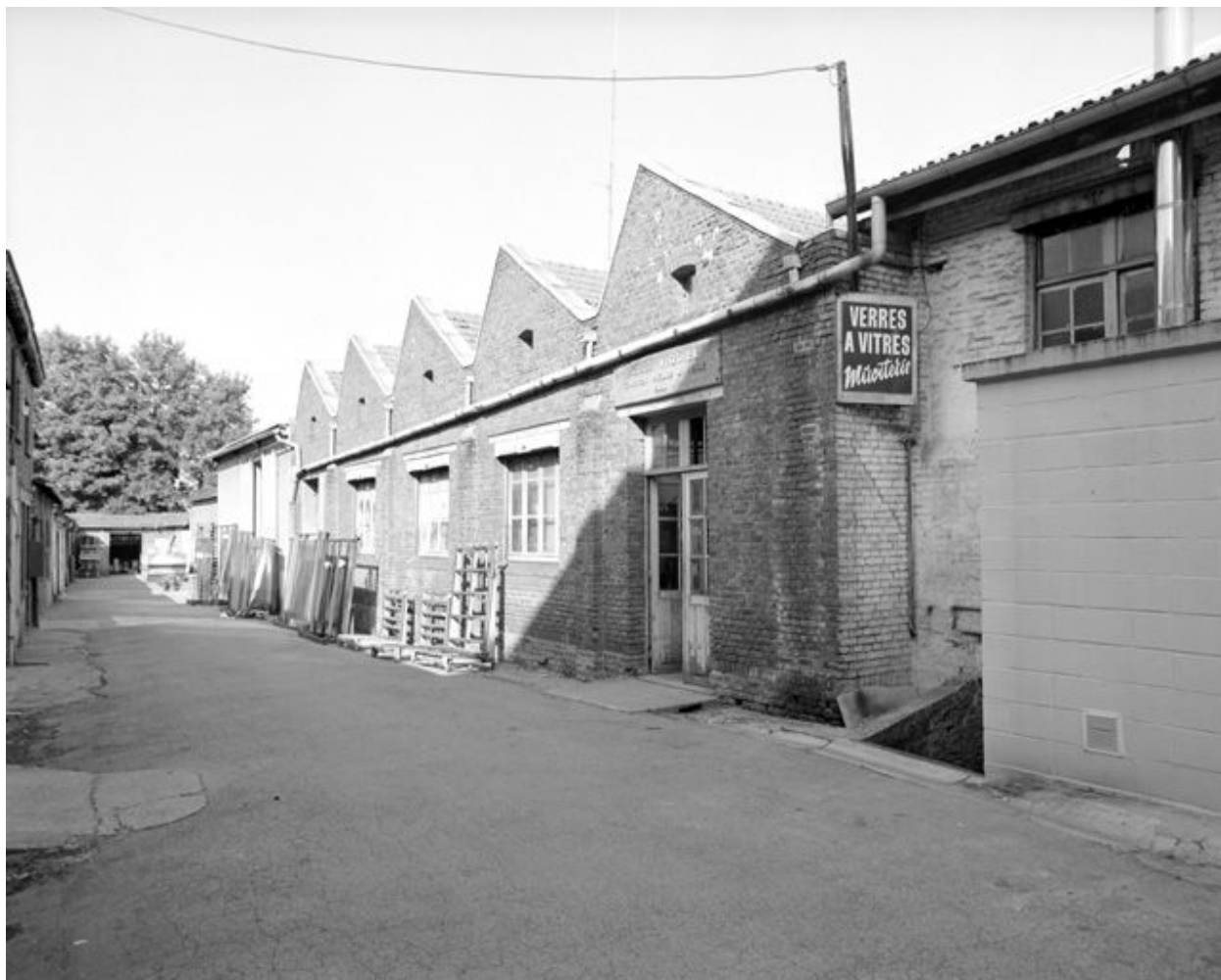
Vue de l'atelier de fabrication, élévation ouest.
