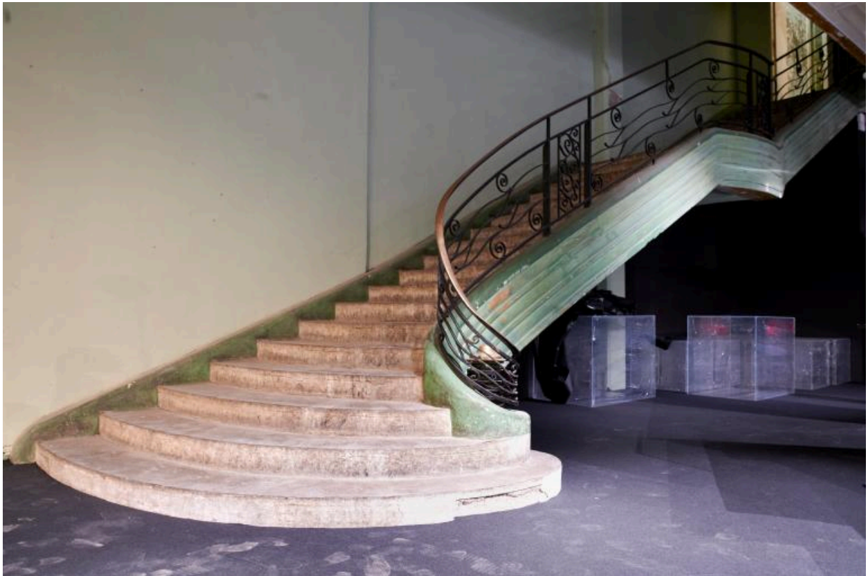
Rampe d'escalier en béton desservant le premier étage.
