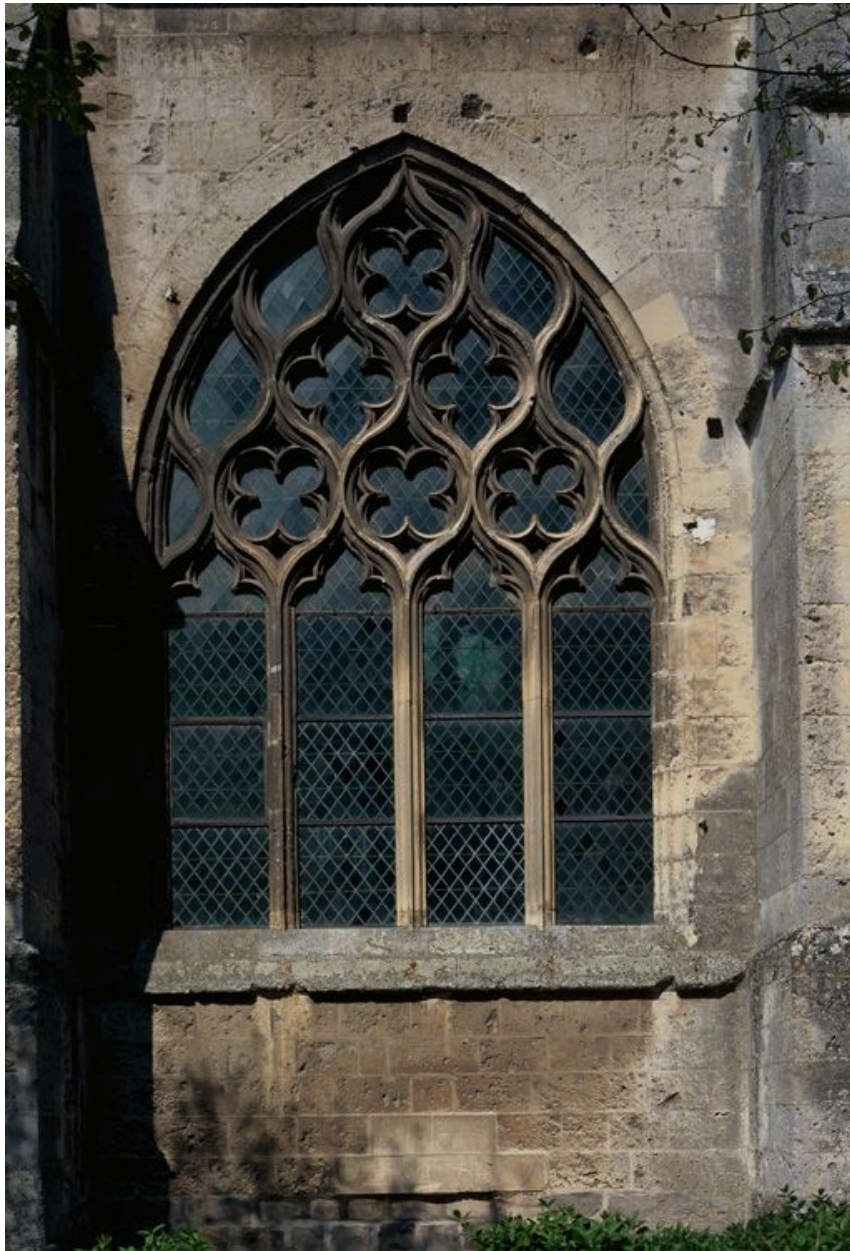
Détail d'une baie de la chapelle Notre Dame de Bon Secours.
