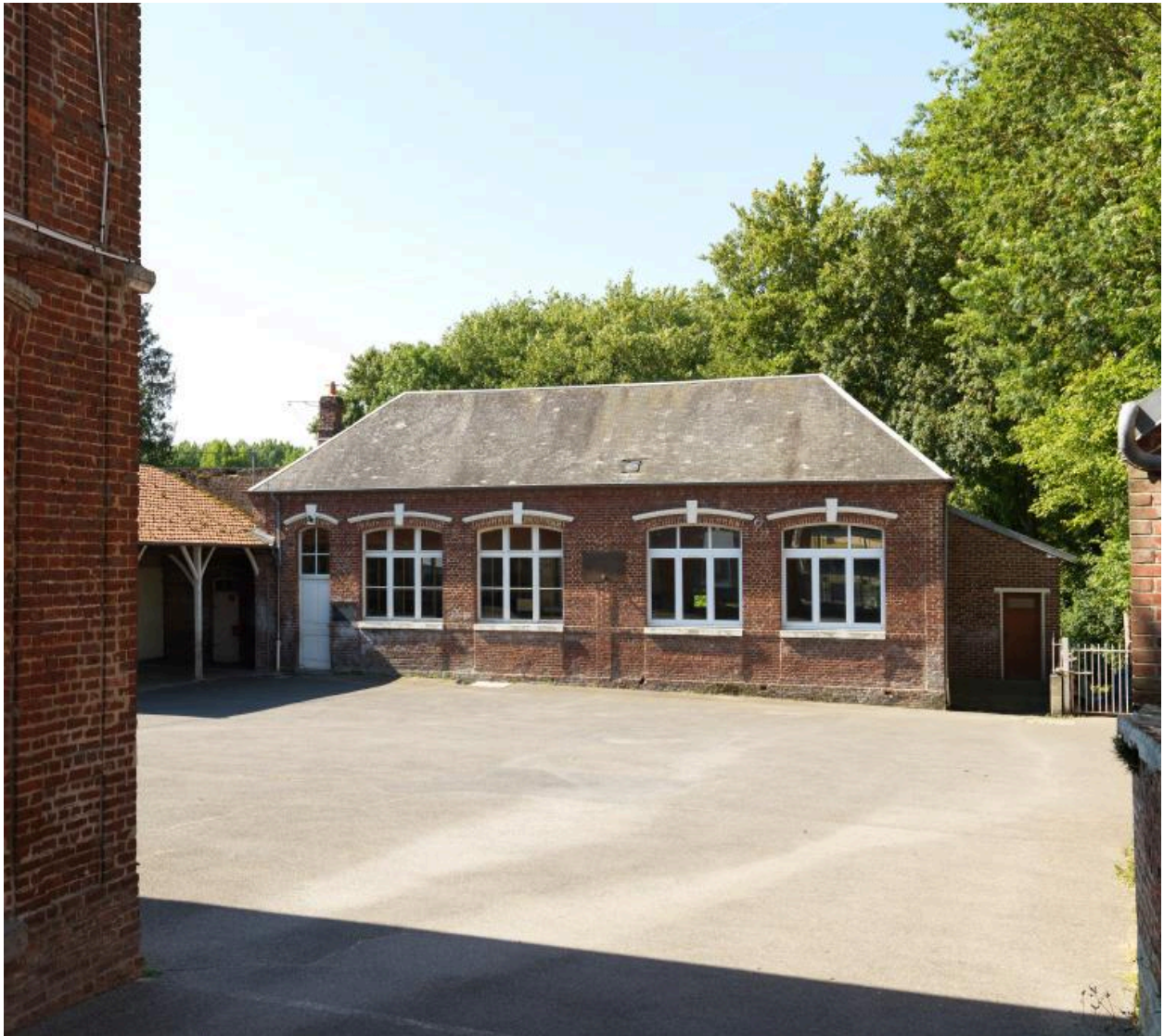
La cour et le bâtiment des classes.
