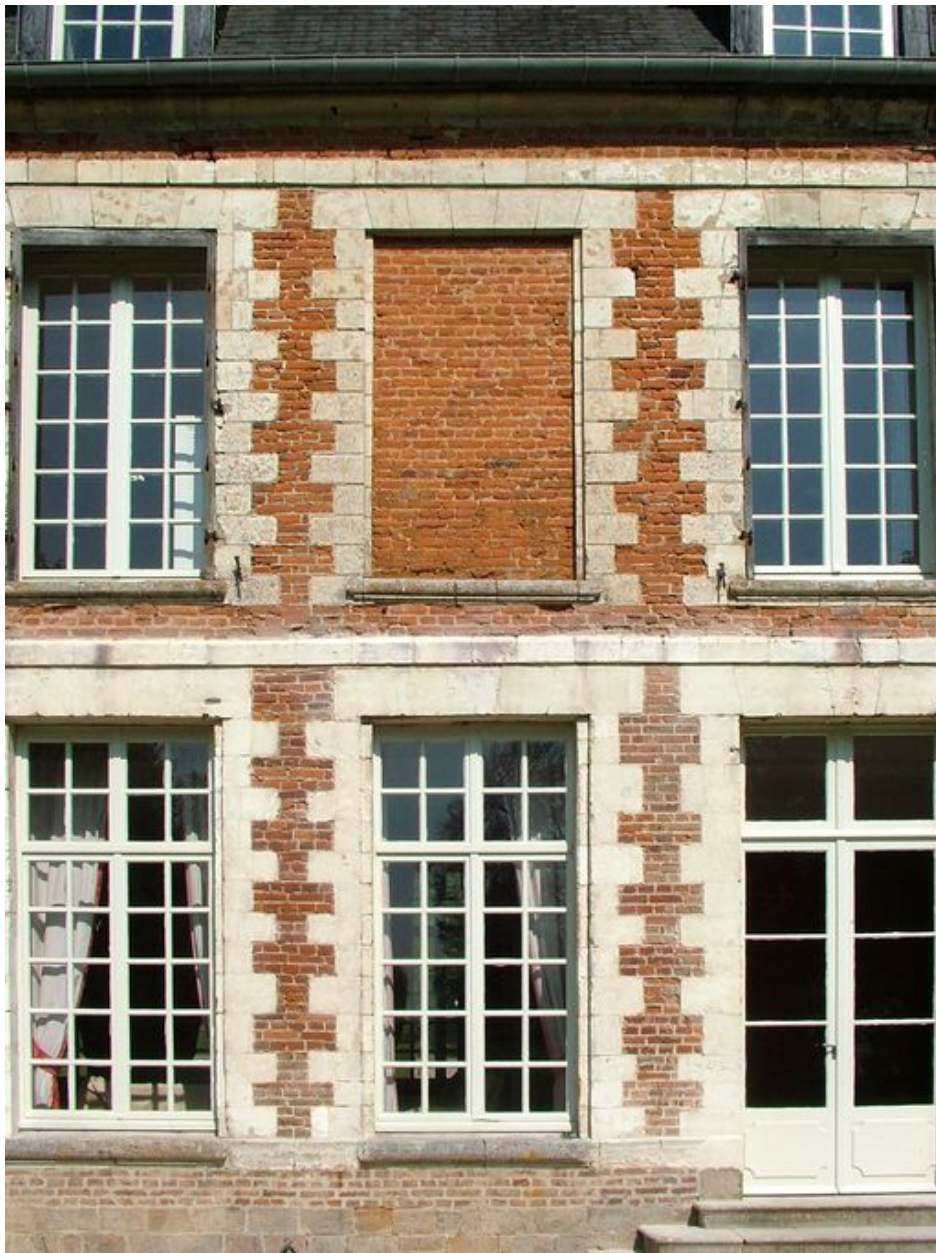
Détail d'une travée de la façade du logis sur jardin.
