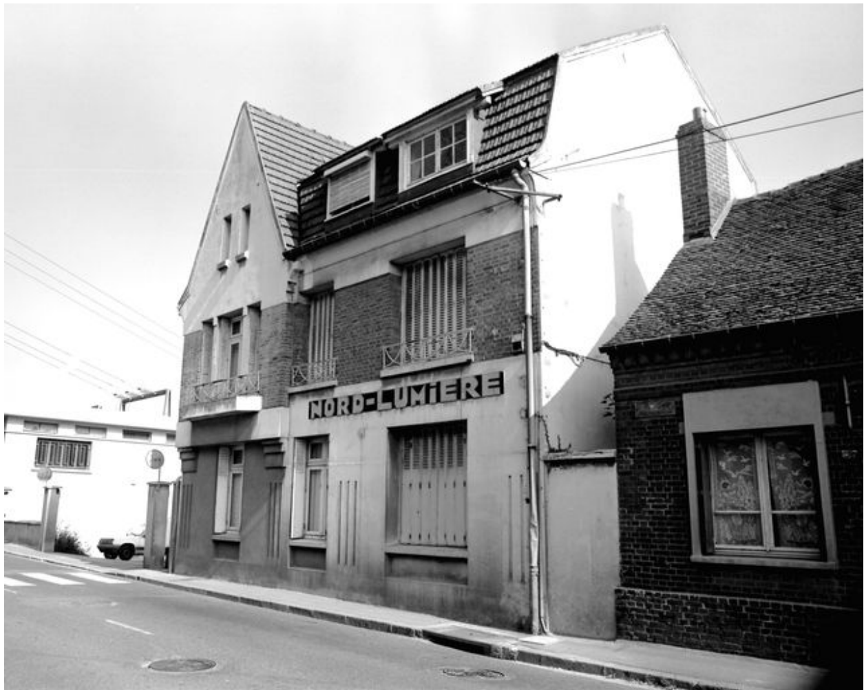
Façade sud du logement donnant directement sur la rue du Faubourg Saint Jean.
