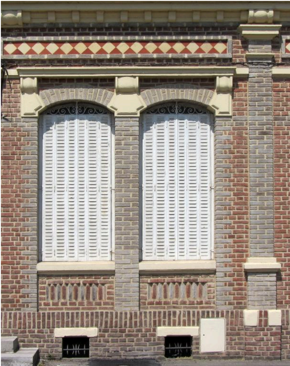
Détail des baies jumelées de la façade sur rue.
