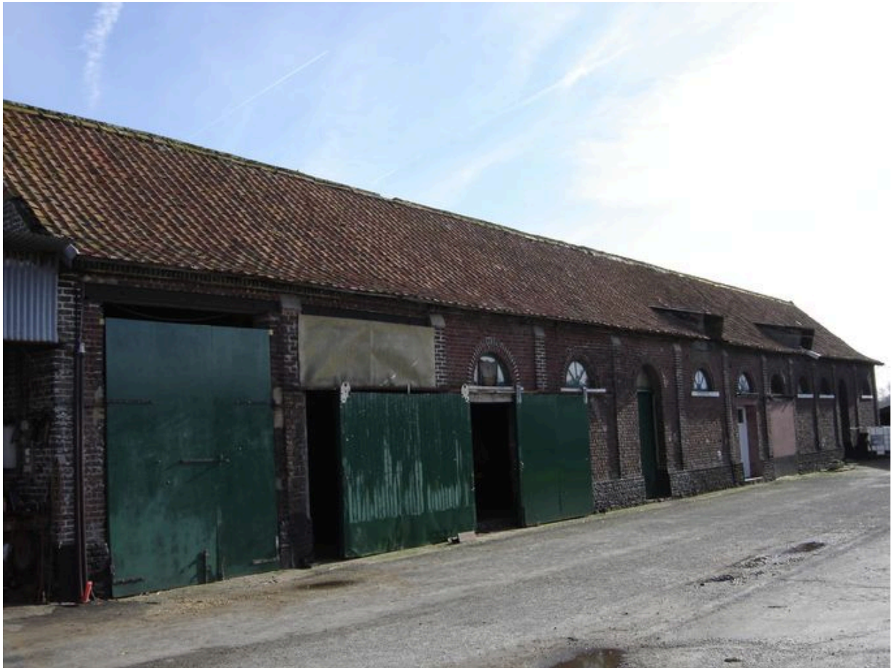
Vue partielle des écuries.
