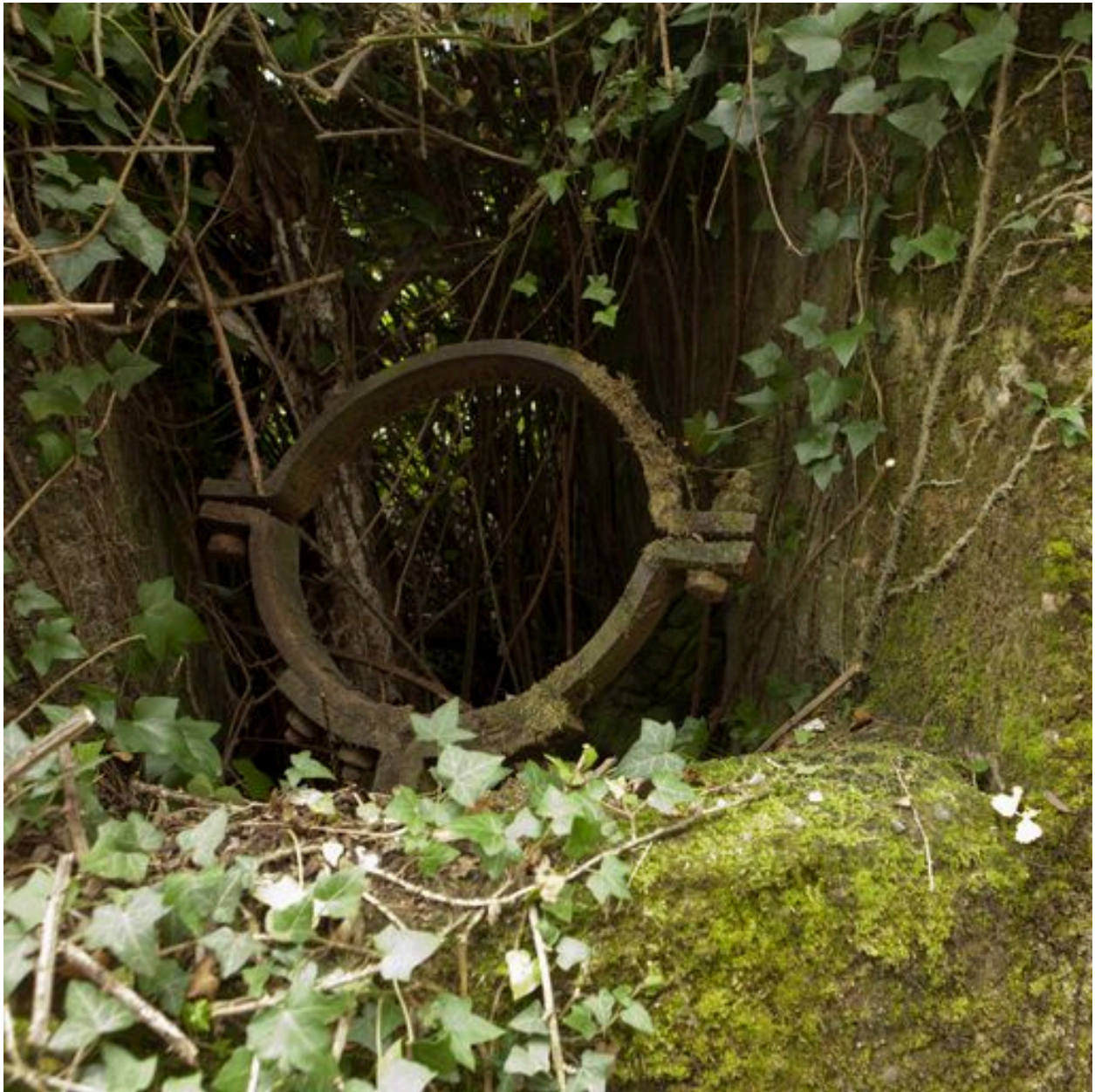
Au sud de l'édifice, collier de fixation d'un des conduits d'évacuation
