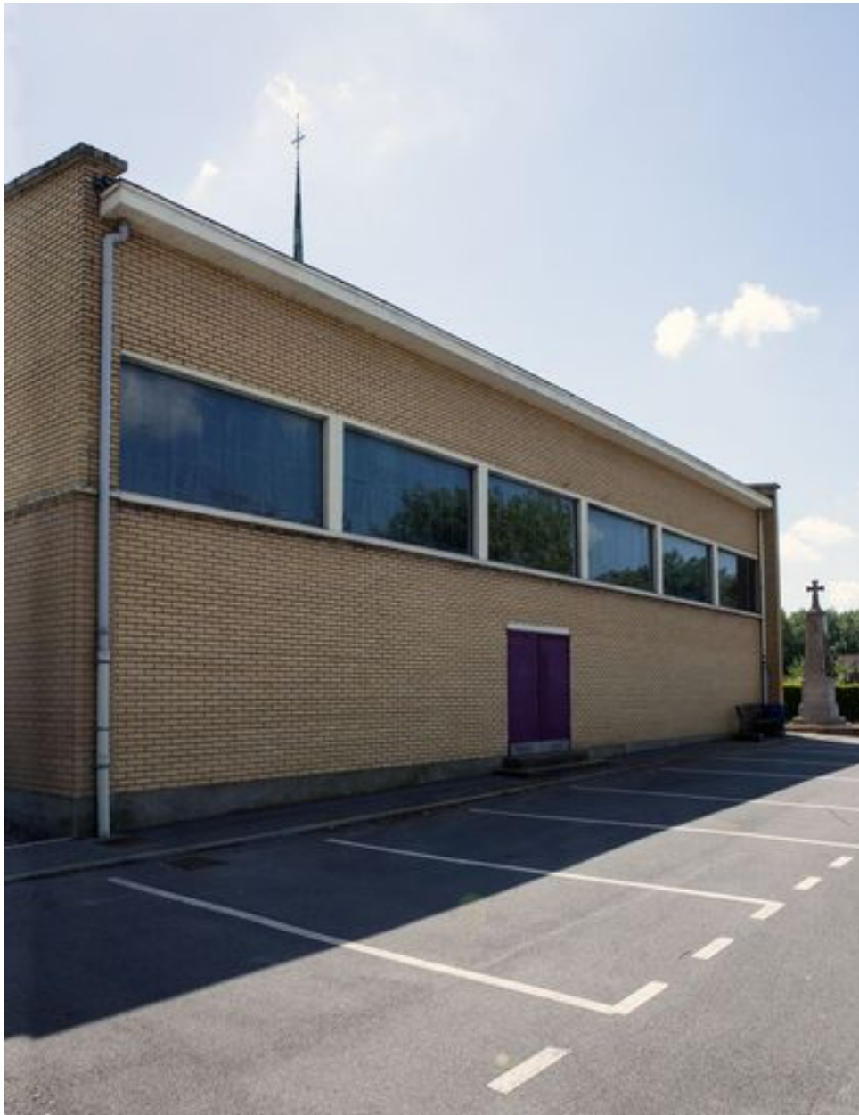
Vue latérale gauche depuis l'arrière de l'église.
