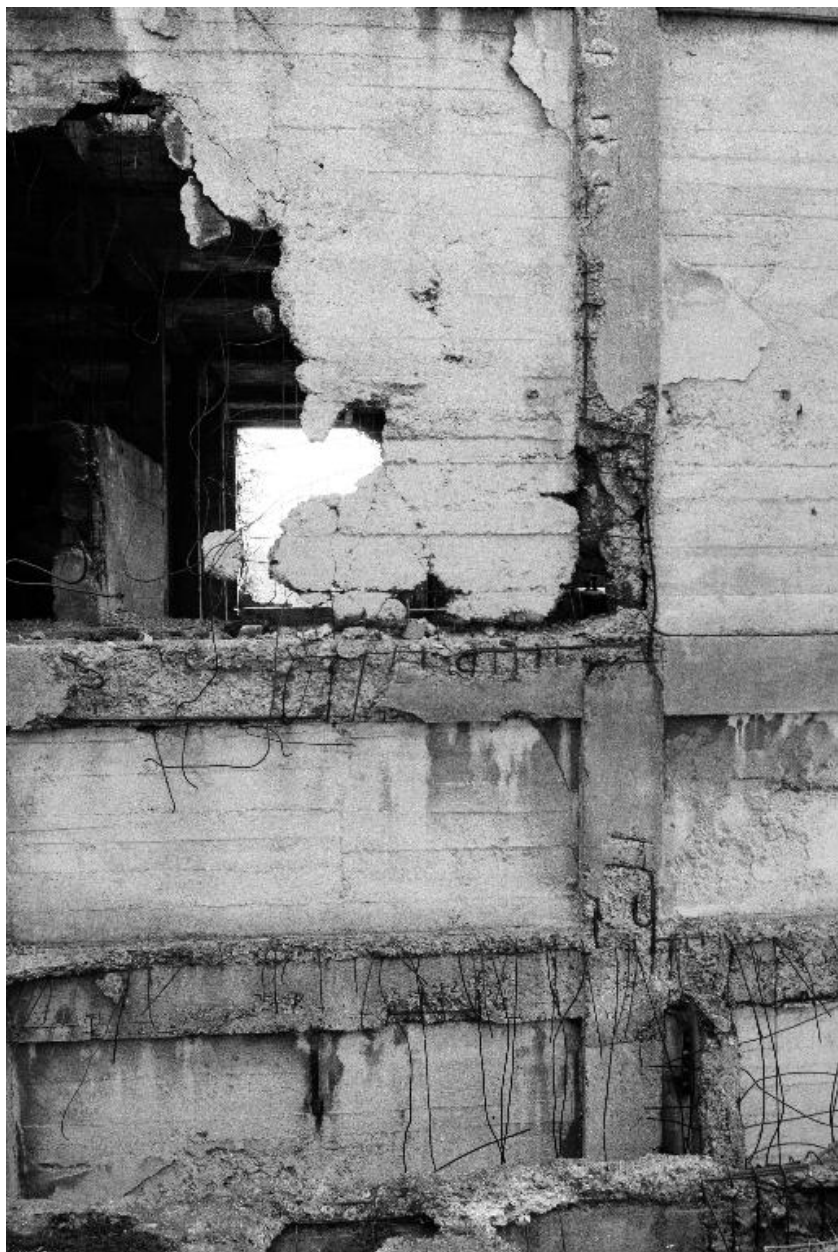
Atelier de fabrication, détail du mur.
