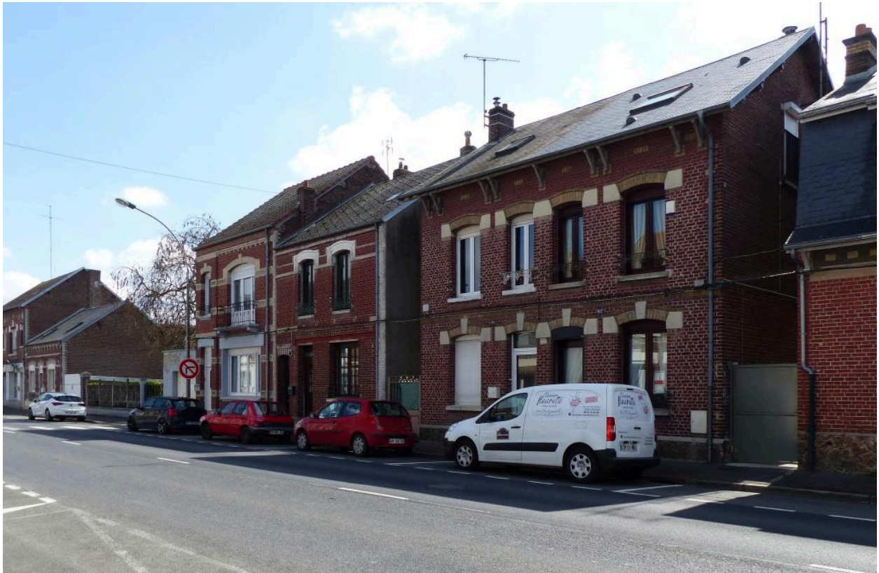
Maisons, 101 à 107 boulevard Gambetta.
