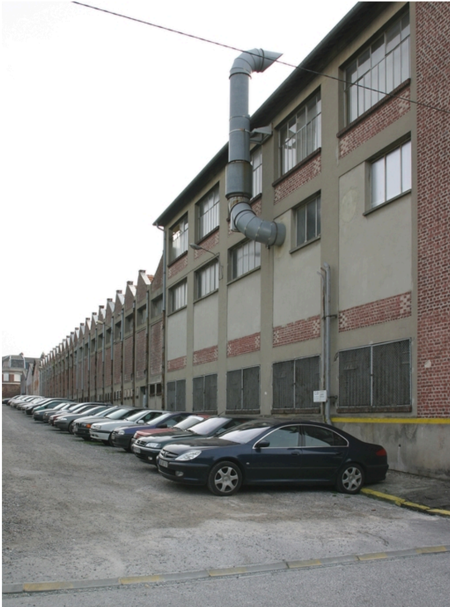
Les ateliers vus depuis le parking des employés.
