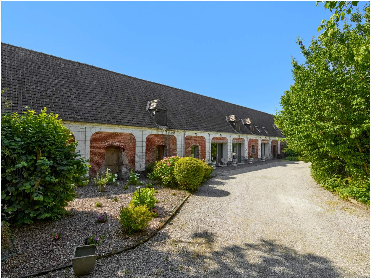
Vue nord du bâtiment sud, depuis la cour.
