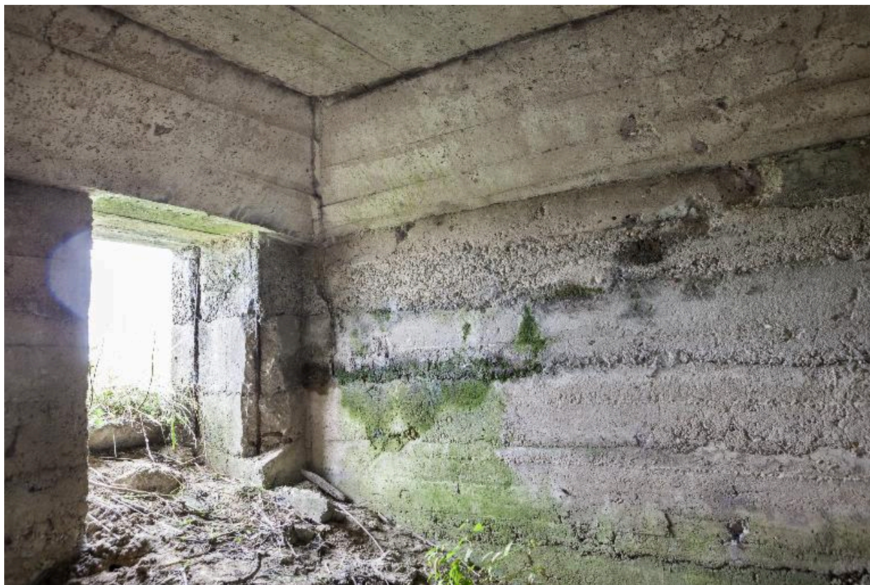
Soute à munition sud.
