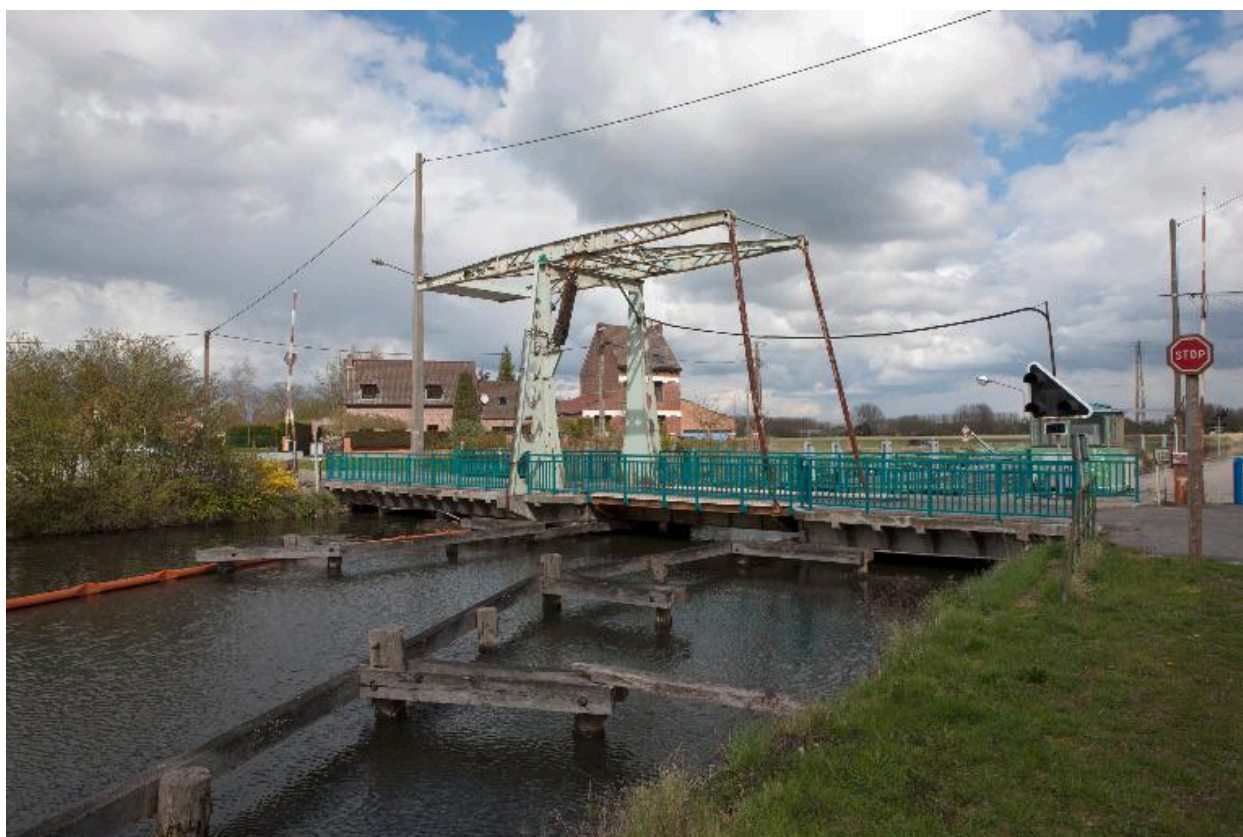
Le pont mobile sur la Scarpe.
