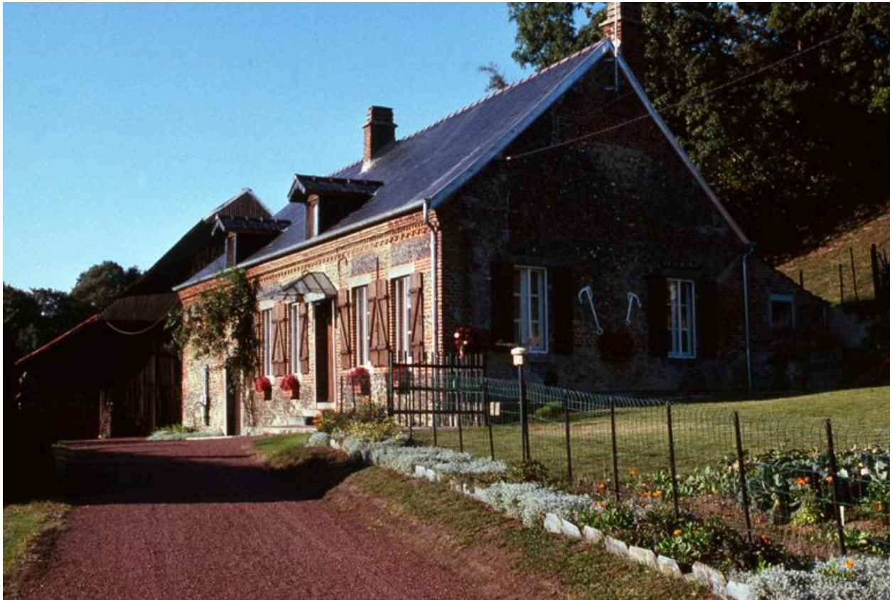
Vue d'ensemble des bâtiments, depuis le sud.
