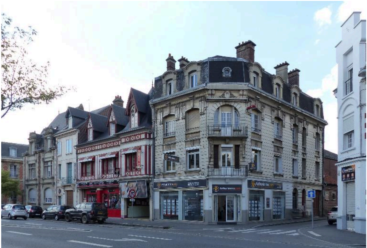
Maisons, rive nord de la rue Saint-Sauveur. A l'angle (B 327), immeuble de rapport reconstruit vers 1927.
