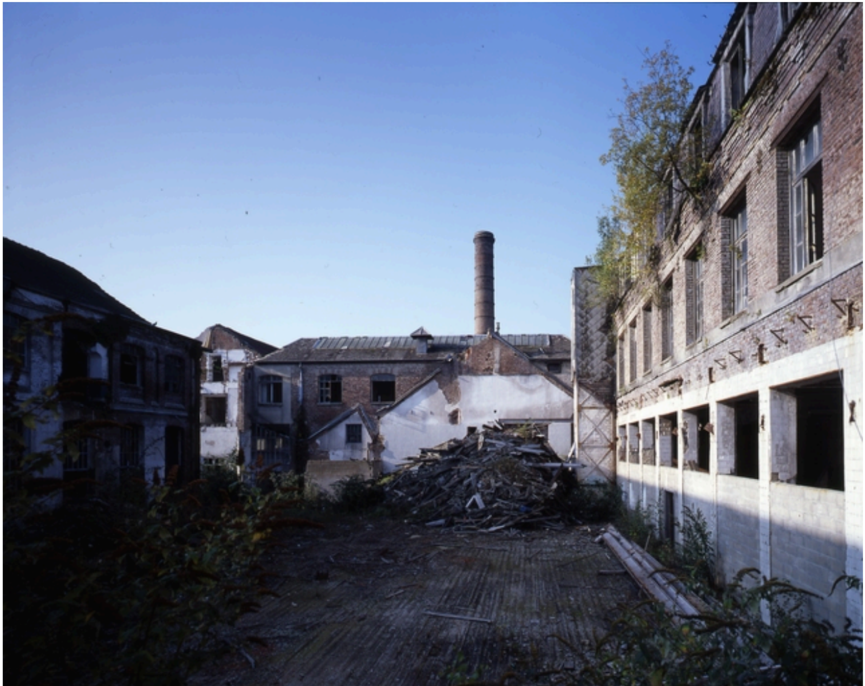
Vue des bâtiments en cours de démolition.
