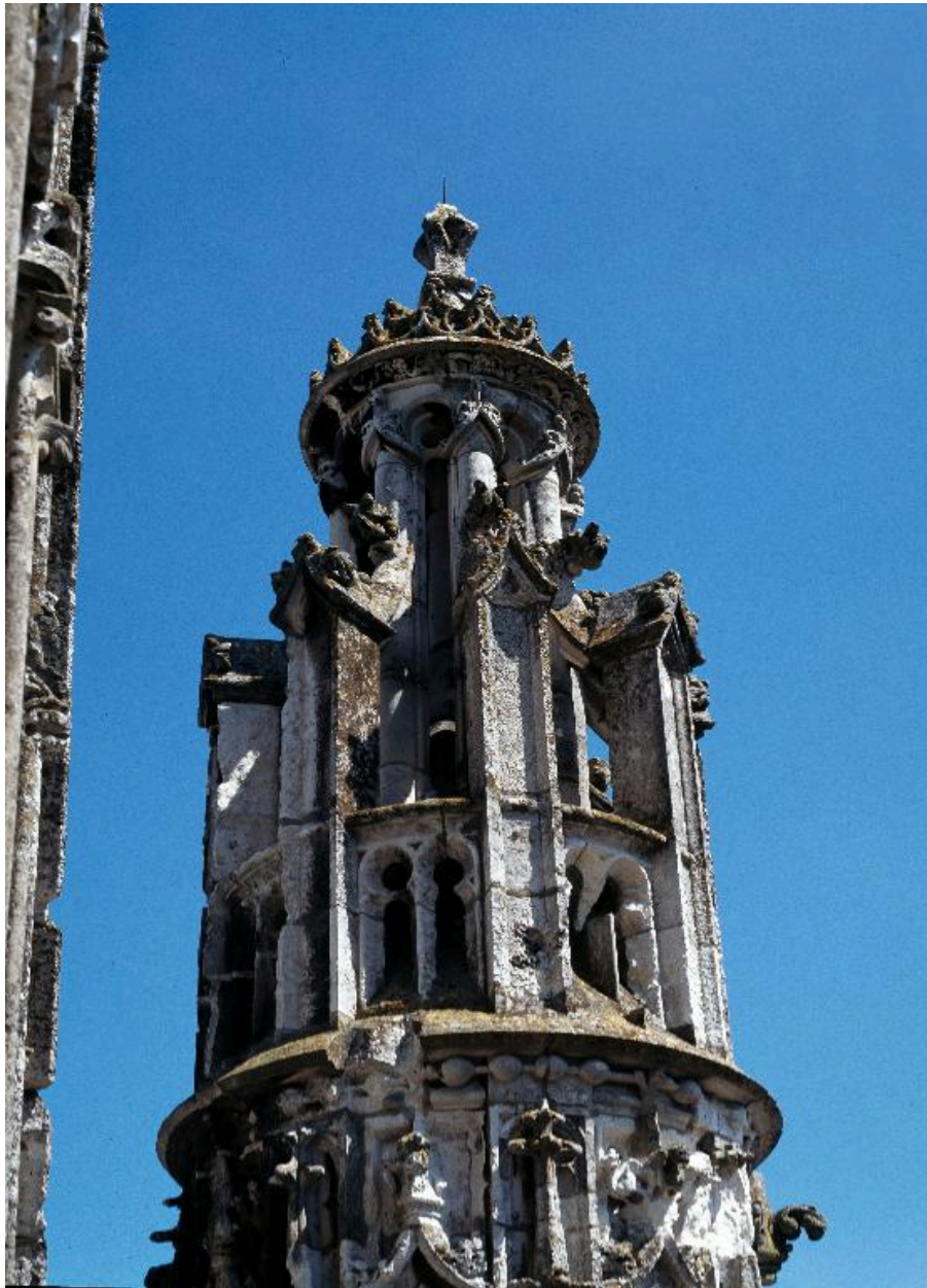
Bras sud du transept : détail d'un pinacle.
