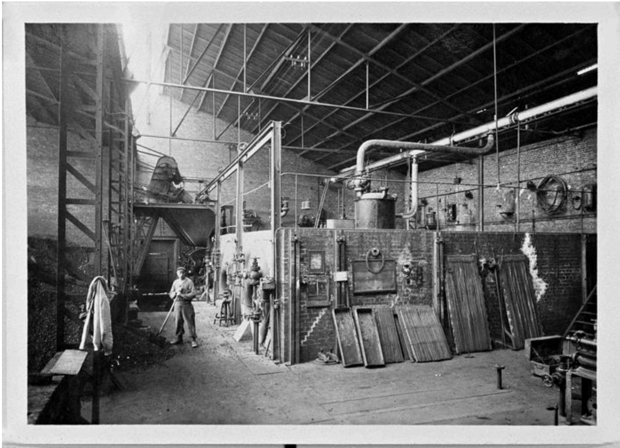
Atelier de fabrication : vue intérieure, vers 1930 (AP).
