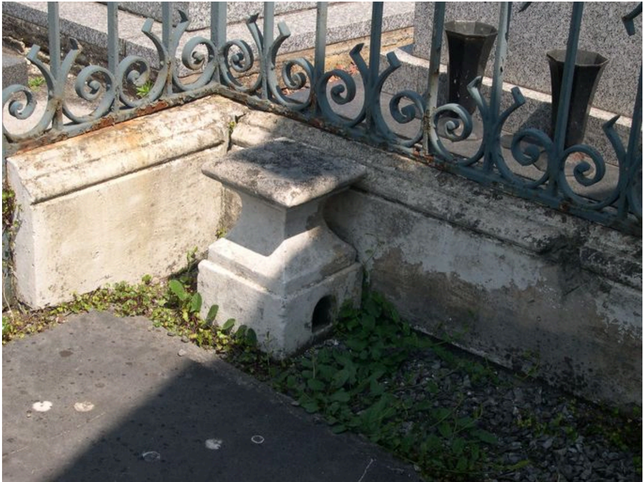
Vue d'une des bouches d'aération du caveau.
