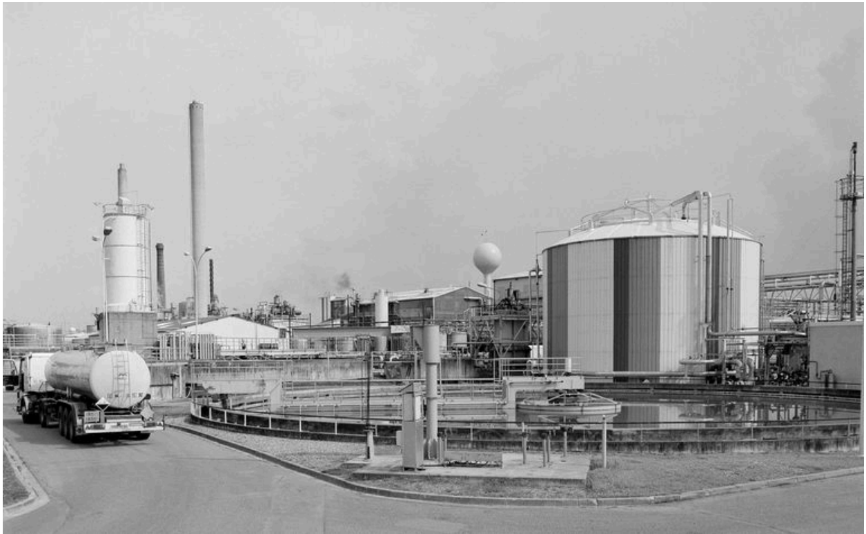
La station d'épuration construite vers 1970.
