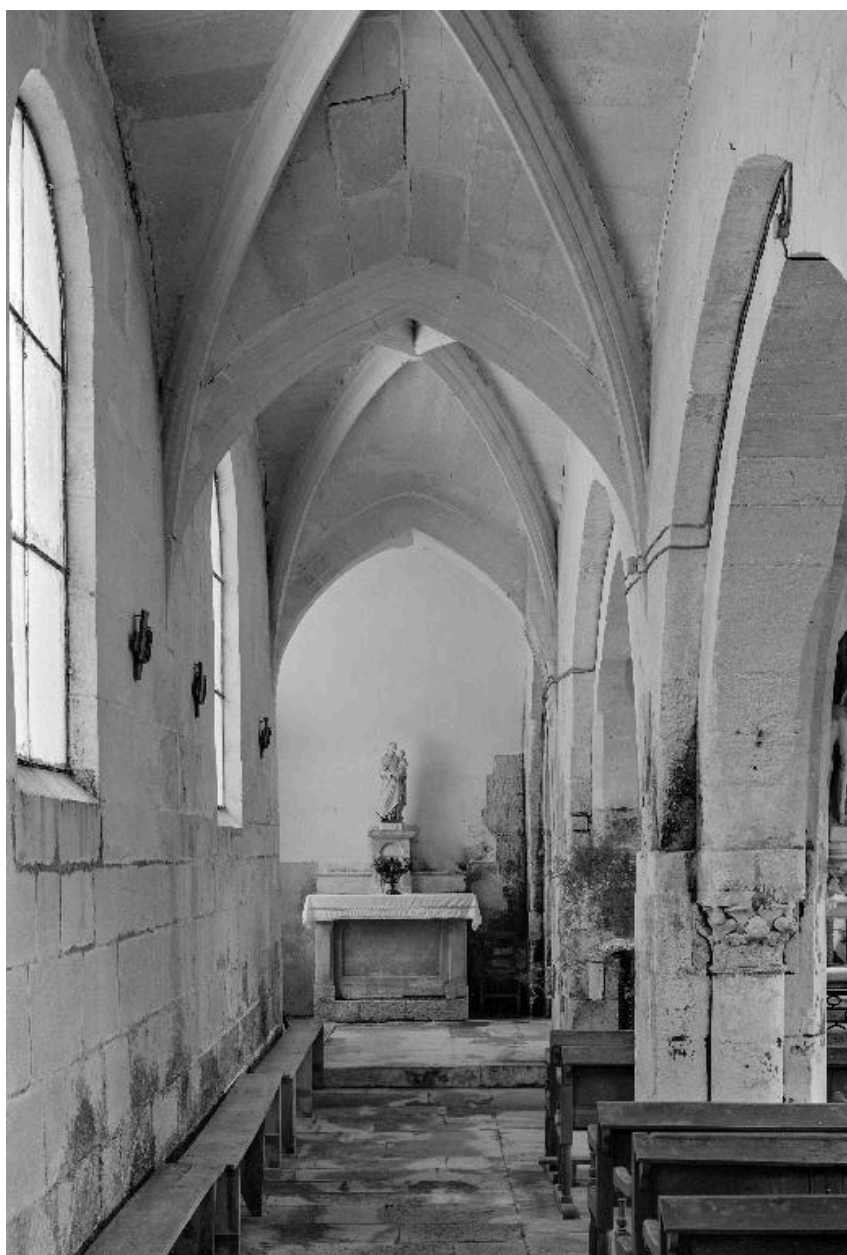
Vue du bas-côté nord, prise d'ouest en est.
