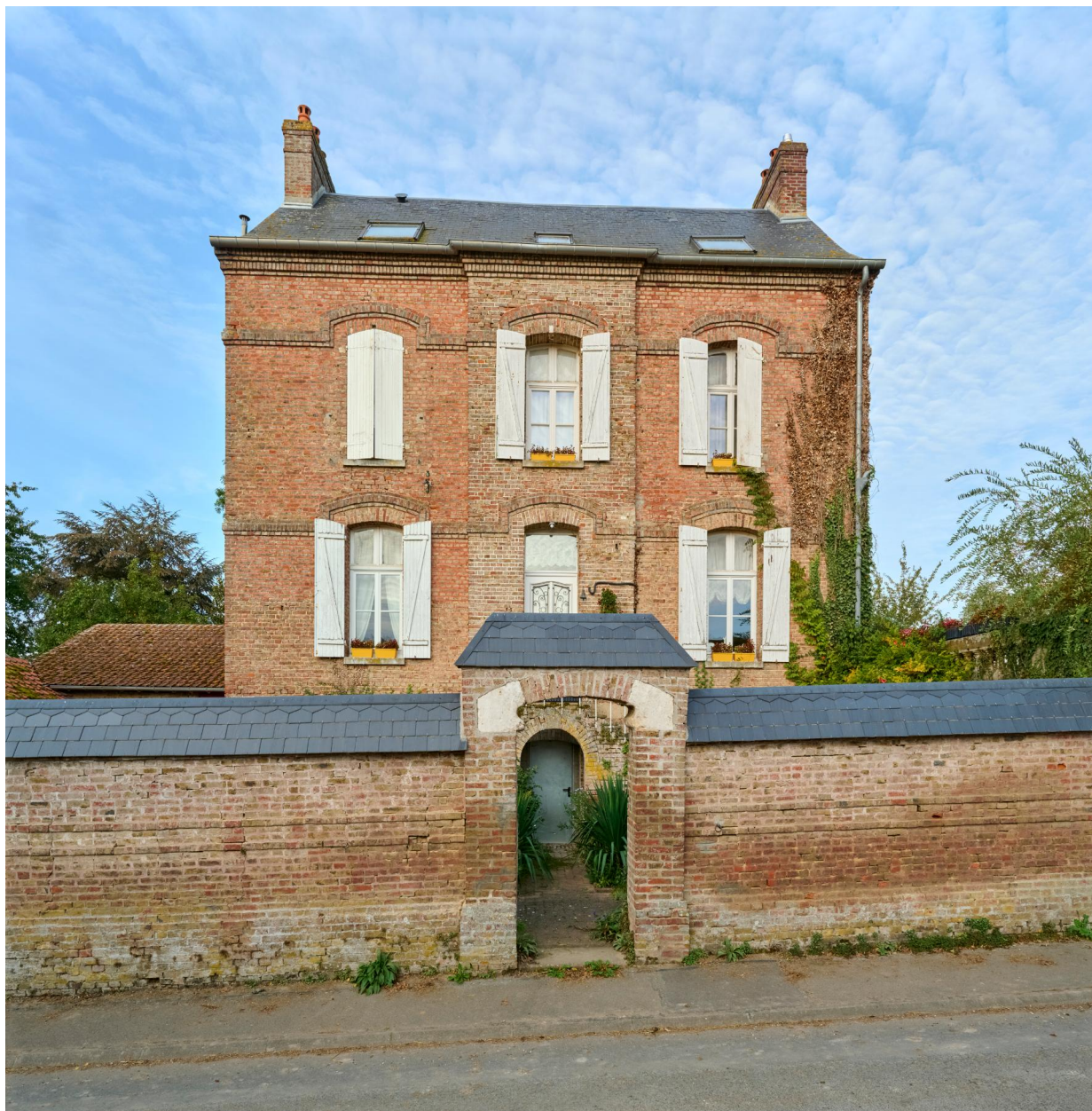
Ancien presbytère, depuis l'est.
