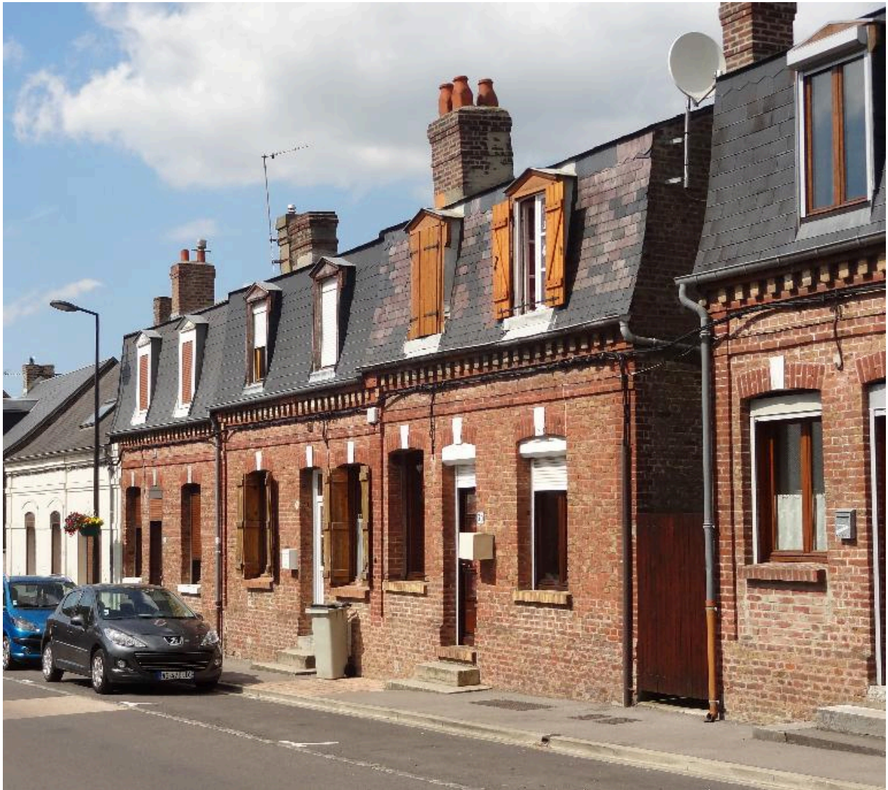
Vue des logements n°31 à 35 rue Jules-Vallès.
