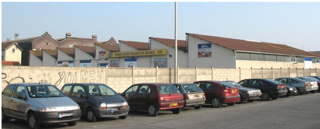
Les ateliers de fabrication depuis le quai d'Aval.
