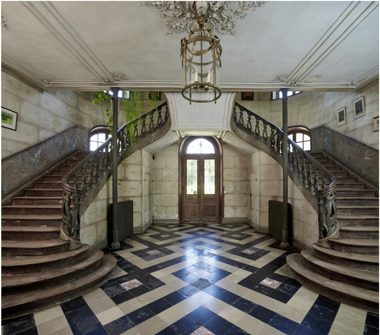
Escalier à double volée du vestibule.
