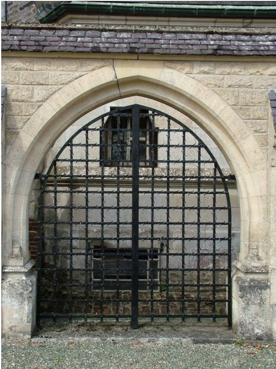
Porte arrière ouvrant vers le caveau de la chapelle.
