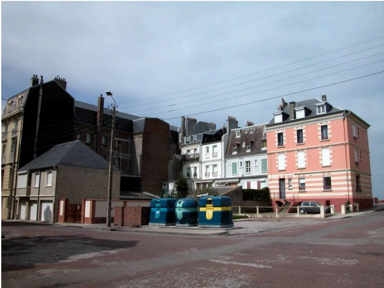
Façades postérieures des constructions d'un îlot situé entre l'Esplanade et la place de la rue Henri-Lefort.
