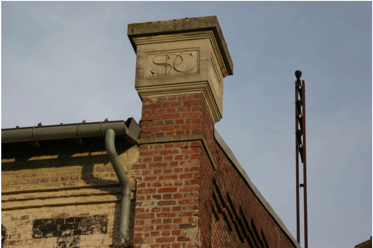
Détail d'un acrotère portant la raison sociale SPC.
