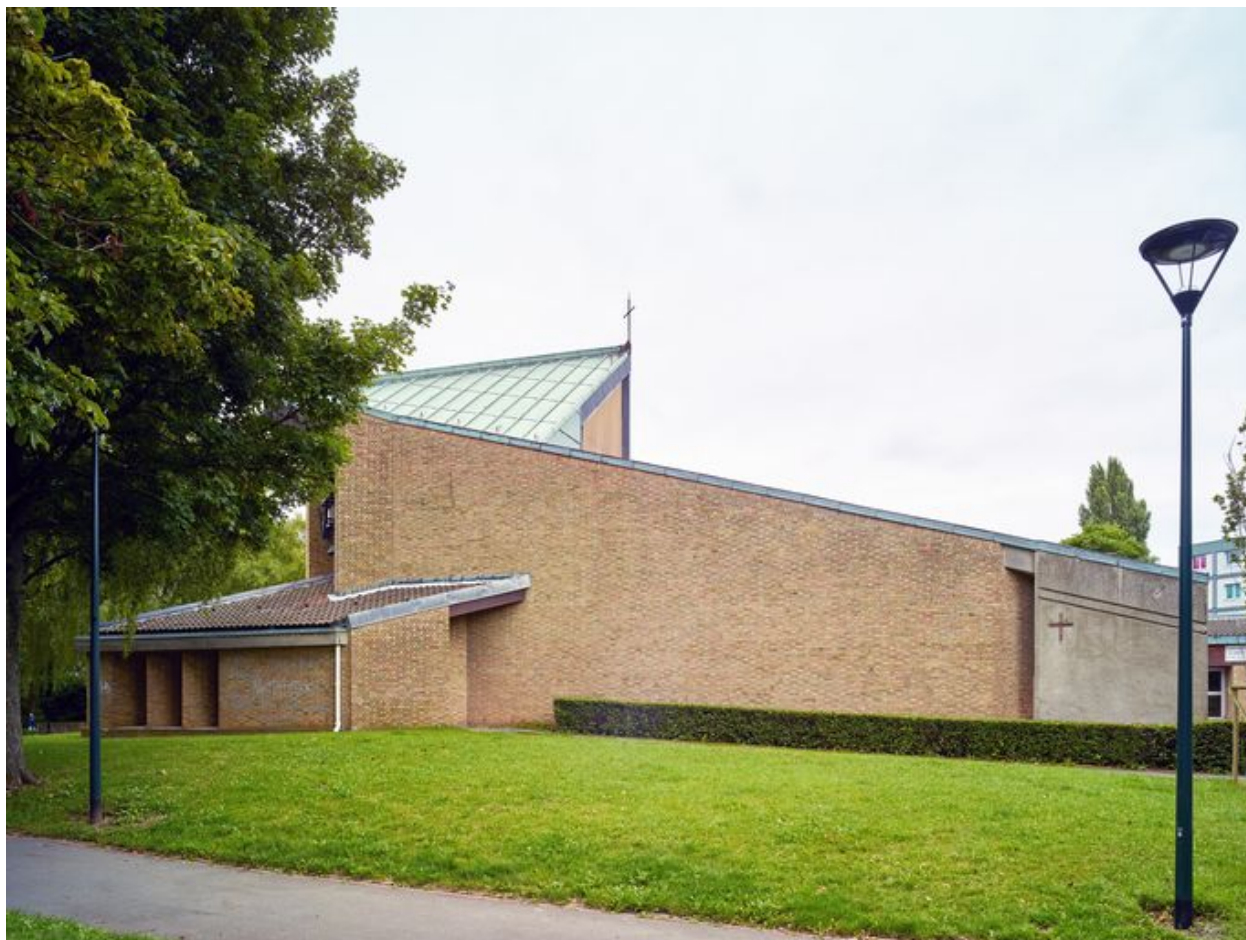
Élévation nord de l'église.
