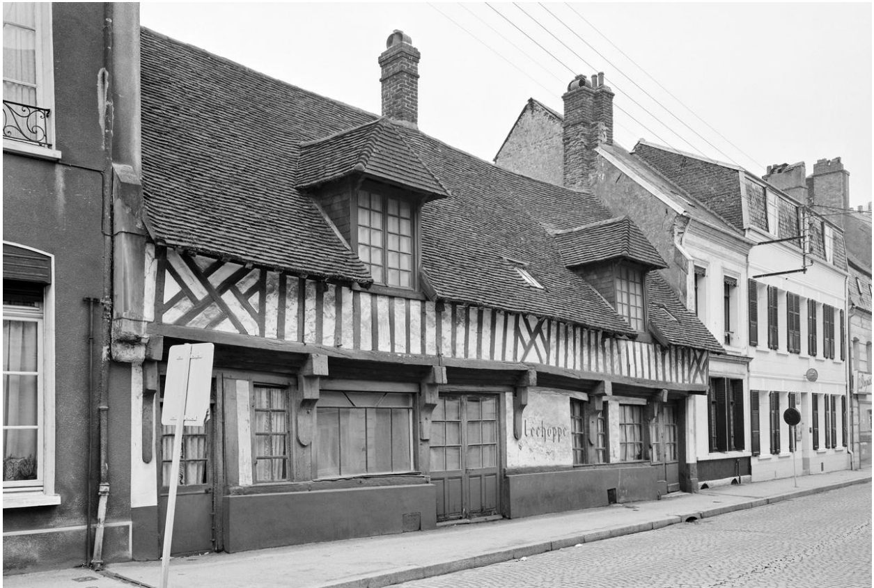
L'Âne rayé et Le Petit-Écu. Façade sur rue (1981).
