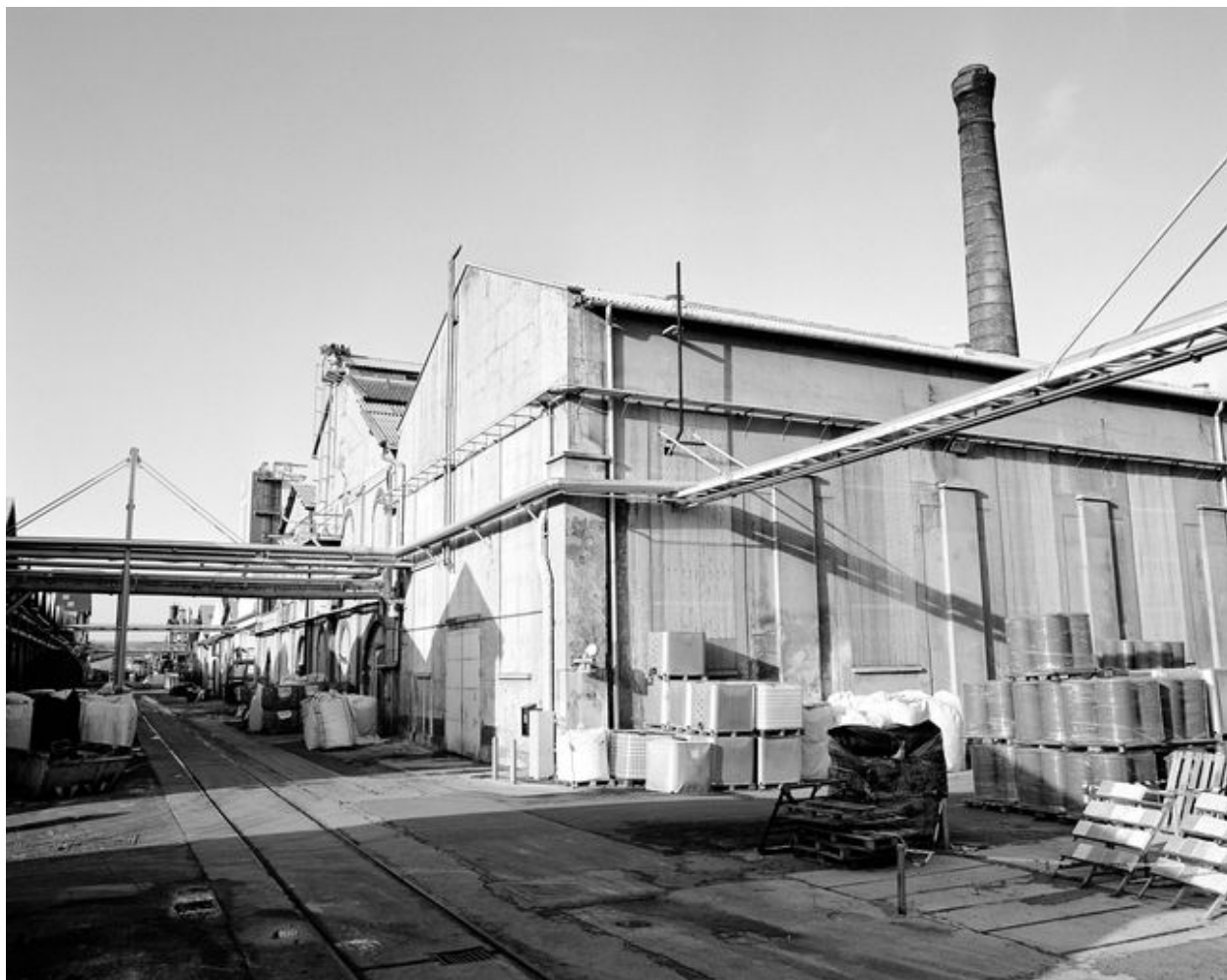
Chaufferie : flanc sud est.
