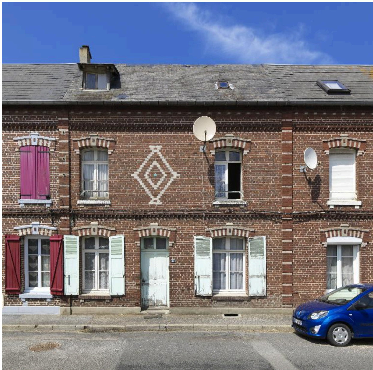
Détail du logement n° 63.
