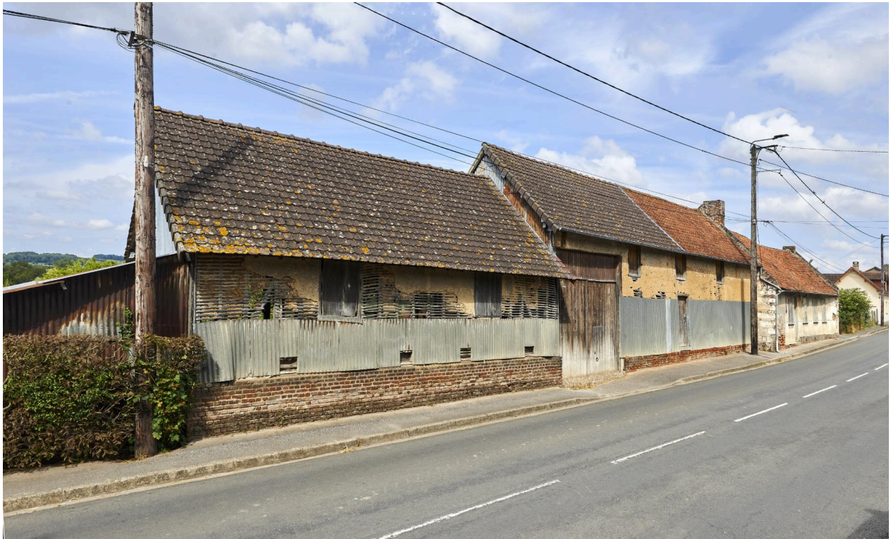
Vue sud des bâtiments agricoles, depuis la rue.
