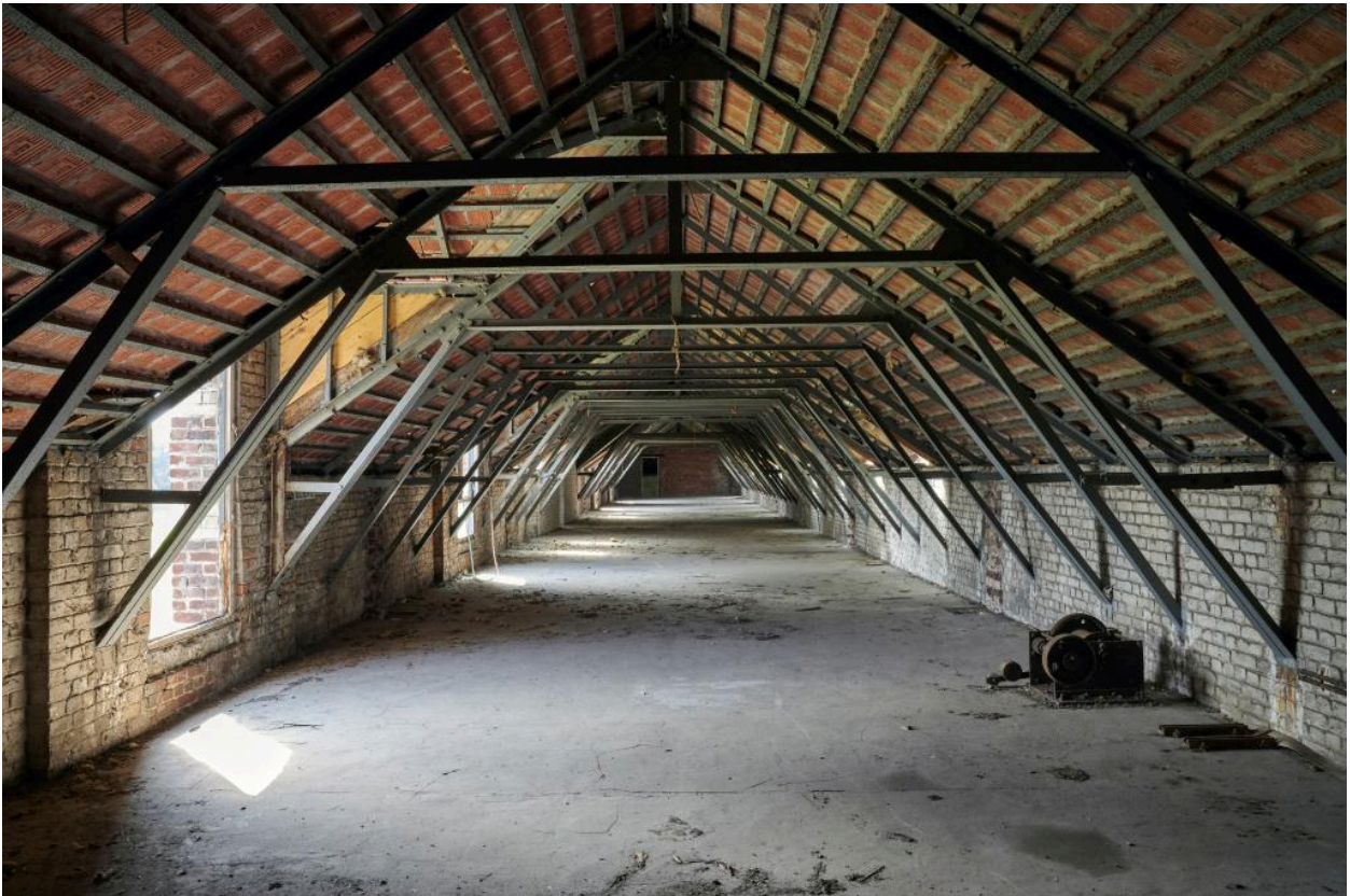
Combles et charpente métallique des anciennes grandes étables.
